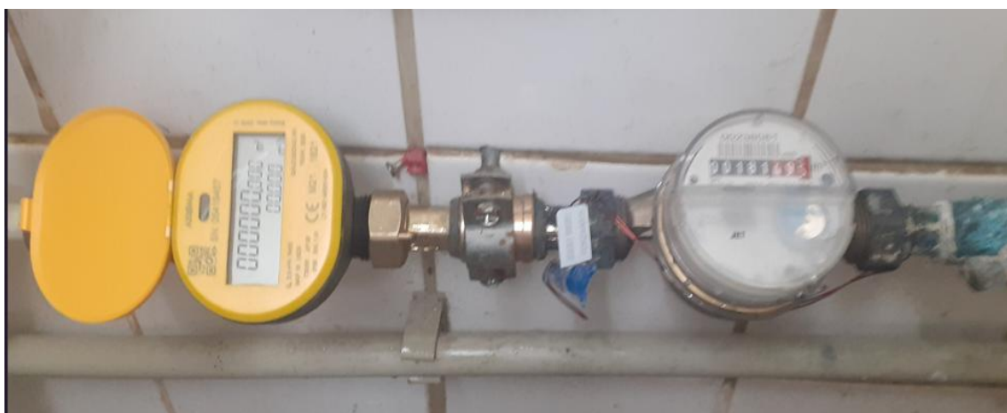
pav. 6 VS1.2 Esamo skaitiklio ir papildomo skaitiklio vizualizacija
