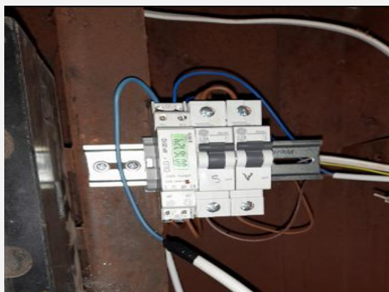
2 pav. 1F esamas elektros skaitiklis
