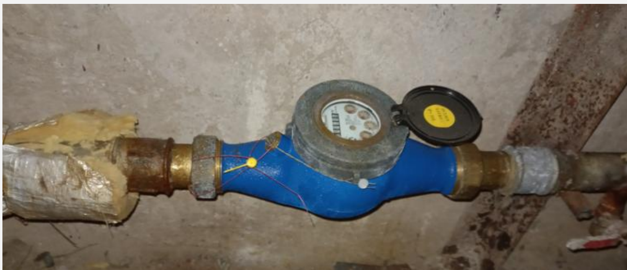
5 pav. VS1.1 esamo vandens skaitiklio vizualizacija
