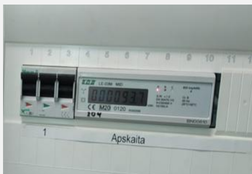
4 pav. 3F pakeistas elektros skaitiklis
