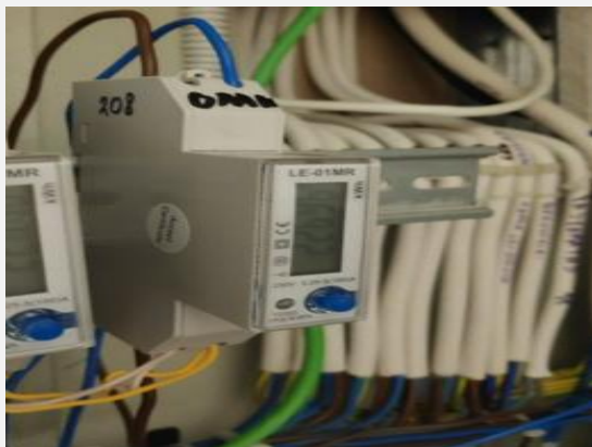
1 pav. 1F pakeistas elektros skaitiklis
