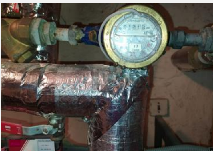
8 pav. VS1.3 sumontuota papildoma įranga ant esamo skaitiklio
