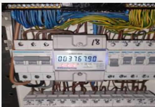
3 pav. 3F esamas elektros skaitiklis
